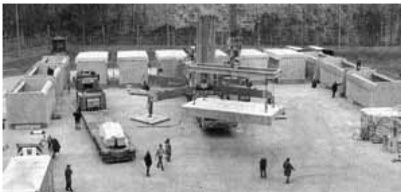
20. April 2001: sechs weitere Betonhauben für den Castor- Parkplatz
